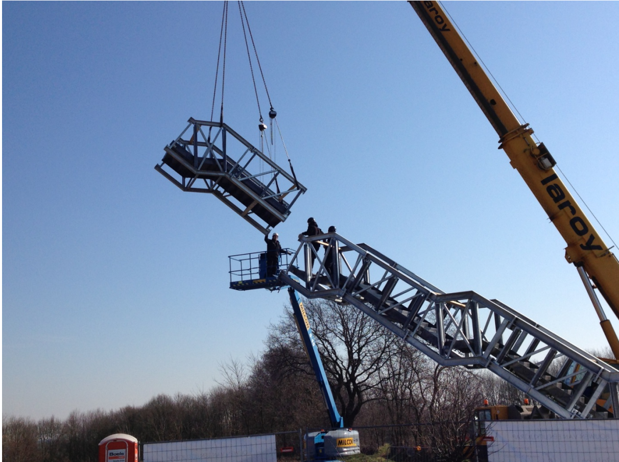
Montage prefab torendelen met reeds ingebouwde trapdelen om de constructie tijdens de montage veilig te kunnen beklimmen
