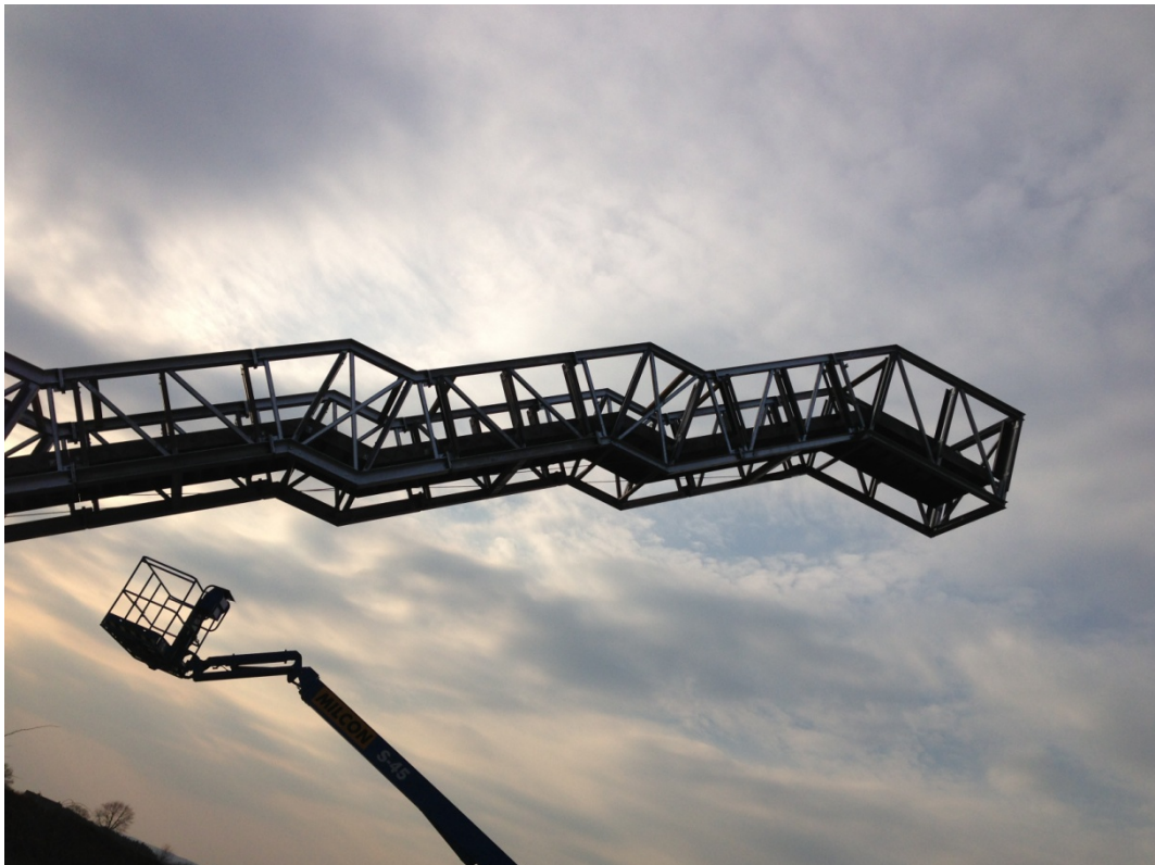
Montage prefab torendelen met reeds ingebouwde trapdelen om de constructie tijdens de montage veilig te kunnen beklimmen
