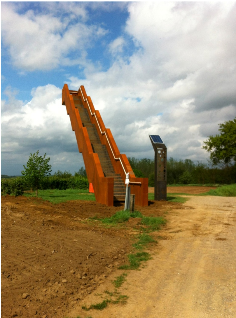
Afgewerkte torentrap - zicht nagenoeg identiek als foto 1 (situatie "voor" - houten uitkijktorentje)
