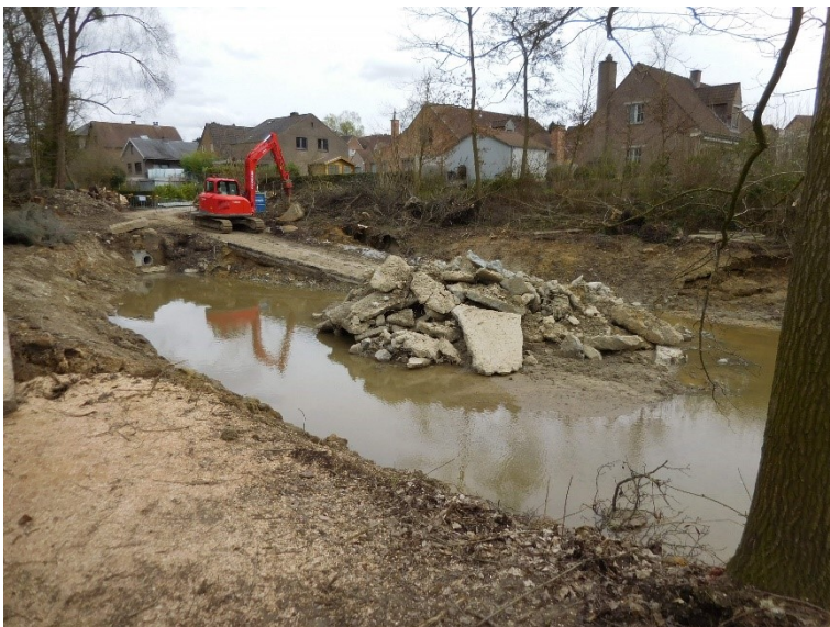
Verwijderen beton uit bufferbekken (tijdens aanleg)
