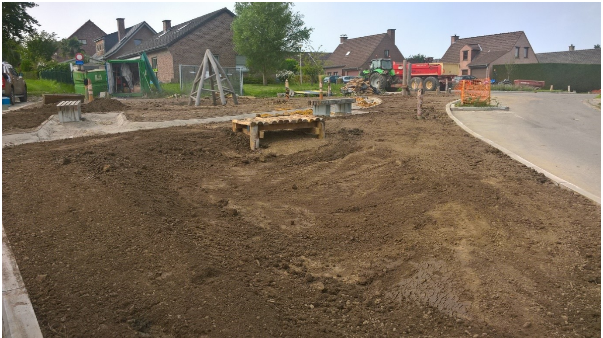
Heraanleg pleintje Geer
