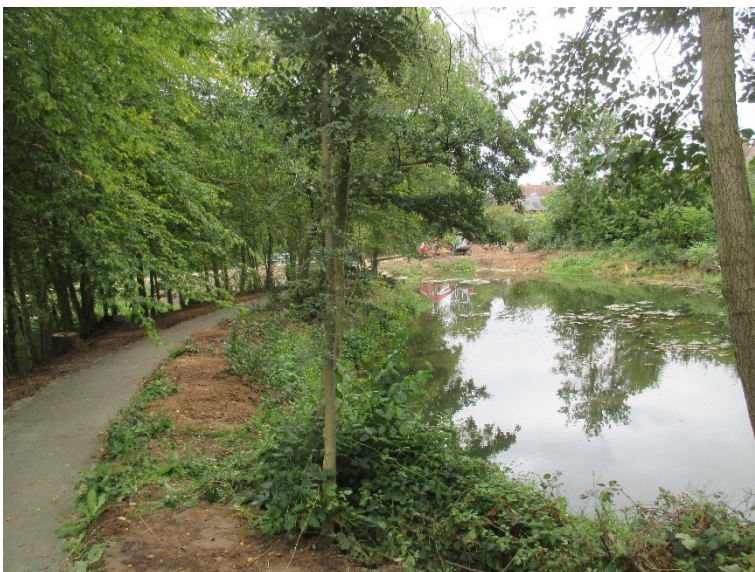
Vijver na verwijderen beton (na aanleg)
