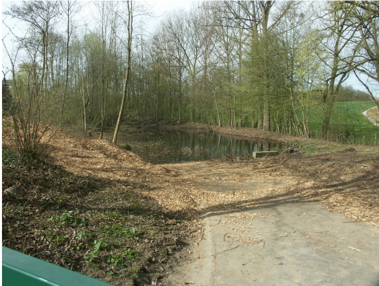
Betonnen bufferbekken (voor aanleg)
