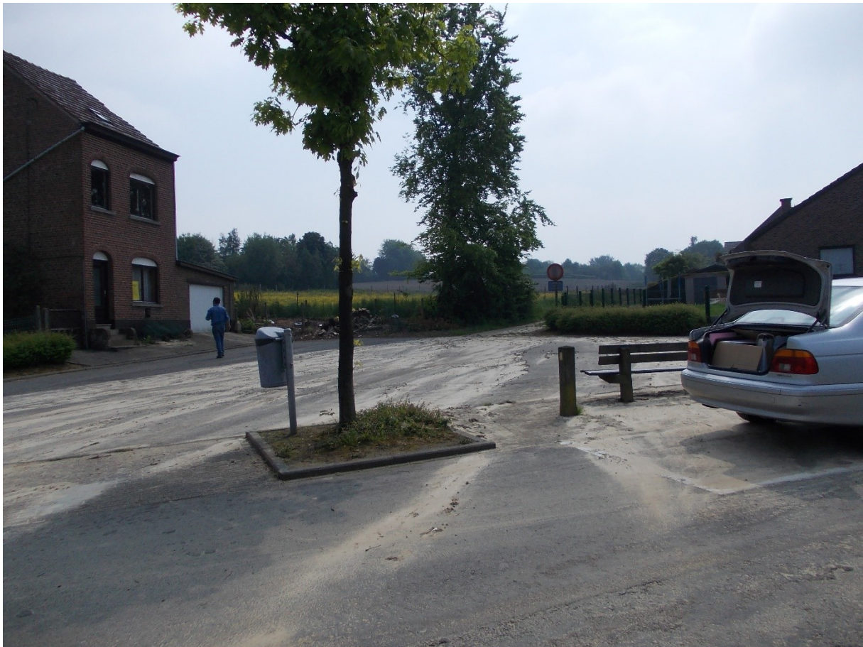
Plein Geer voor heraanleg
